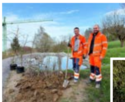
Vorbereitung der Heckenpflanzung
